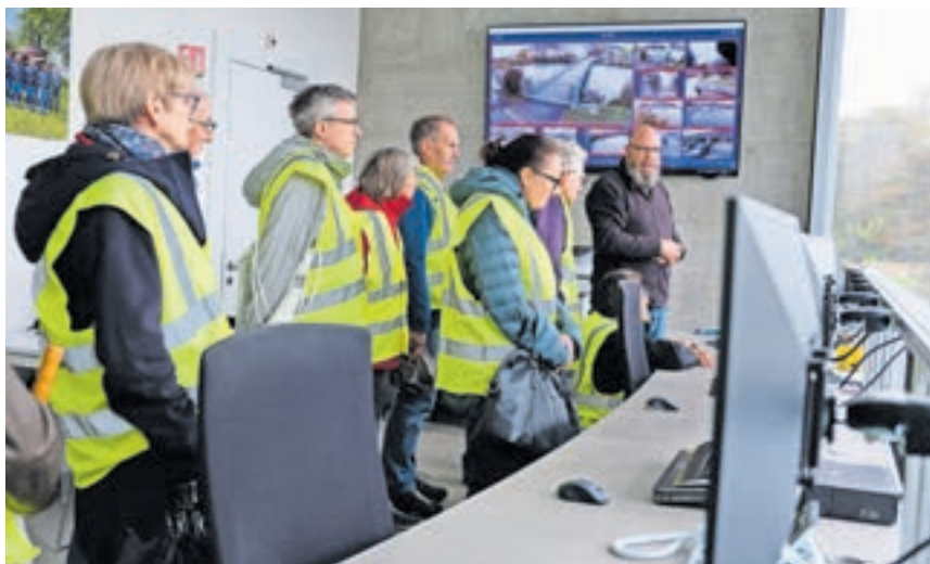
Der Kontrollraum: viel Elektronik steuert das Kraftwerk
