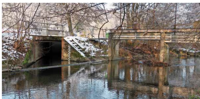
Wasserableitstelle an der Suhre oberhalb von Suhr
