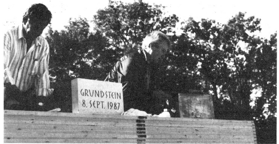
Grundsteinlegung für die vierte Telli-Wohnzeile
