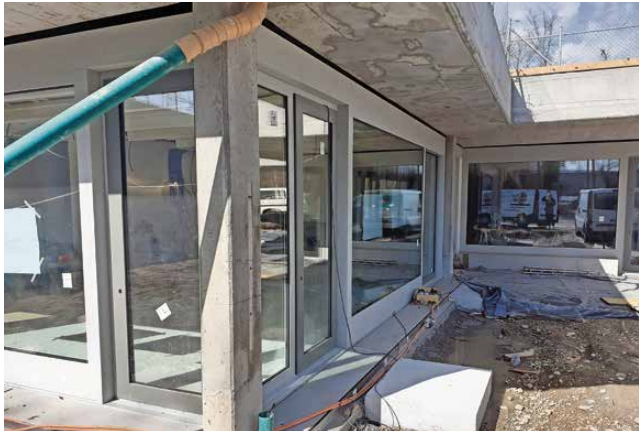
Verglaste Aussenfassade beim Telli-Treff
